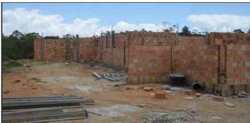
Figura 5. Vista frontal de canteiro de obras do Centro de Prática Clínica e Cirúrgica em janeiro de 2012.
