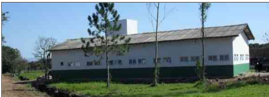
Figura 3. Vista lateral do Laboratório de Ensino e Diagnostico Veterinário (LEDVET).
