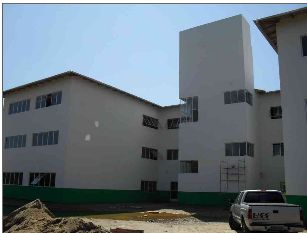
Figura 4. Vista frontal de prédio denominado Bloco H.
