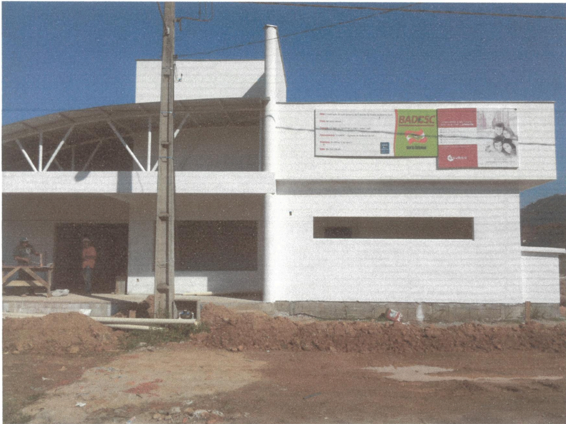
IMAGENS DA OBRA REFERENTE AO ATESTADO DE CAPACIDADE TÉCNICA 313332 – Construção do posto de saúde do bairro Avai em Gauramirim – SC. (fonte própria). É possível verificar que essa obra foi construída com laje inclusive o beiral.
